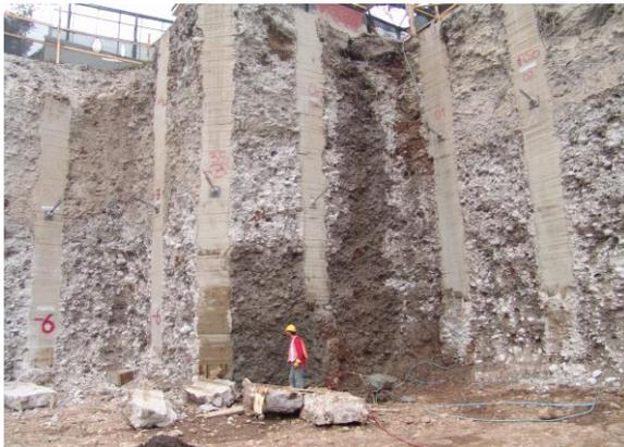
Solución para muros contra terreno: proyección de mortero polimérico impermeable fabricado con aditivo SelleNite ADM
